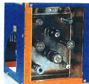
油圧ホース接続部
